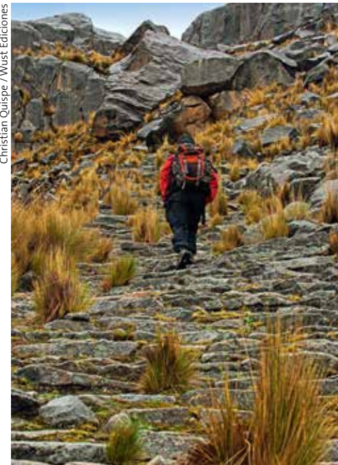
▲ Casi un millar de peldaños elaborados con lajas canteadas permiten a los caminantes sortear un desnivel en el camino en Escalerayocc.
